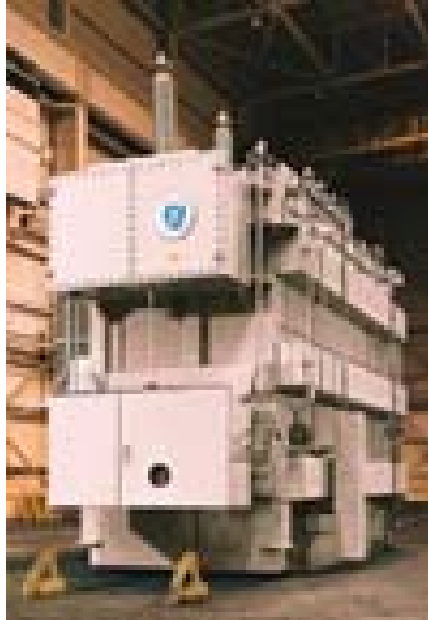
1. ábra A transzformátorok diagnosztikájának elterjedt, egymást kiegészítő módszerei: termográfia, olajvizsgálat, gázelemzés, szigetelésvizsgálat
